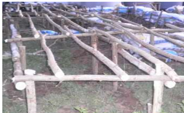
Hình 12. Giá đỡ của hệ thống lọc sinh học
